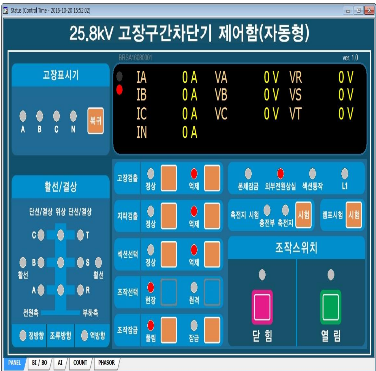
그림 7-6 [Tap] - Control Panel
